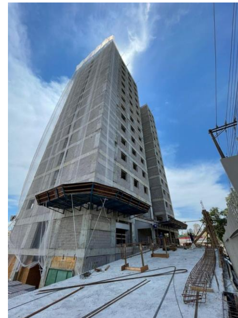
Fotos cedidas pelo cliente - Andamento da obra em outubro de 2021
